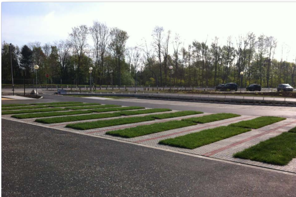
Source : Parking de l'université de Valenciennes (59) - INFRA Services
