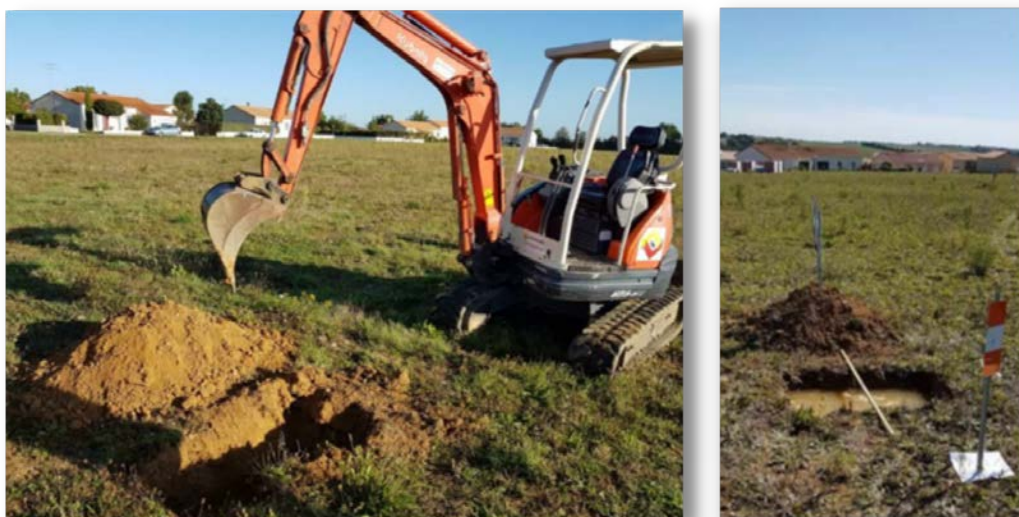
Source : Photographie de chantier - INFRA Services
