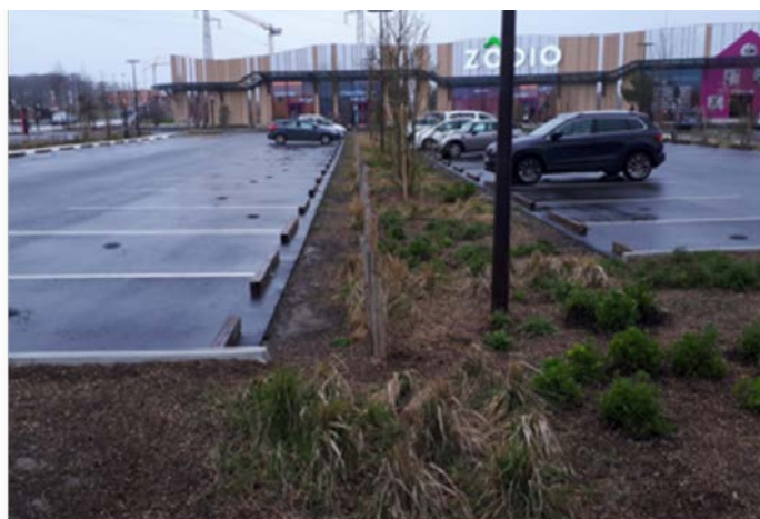
Source : Parc de stationnement en enrobé classique et noue – Cap Saran, Saran
