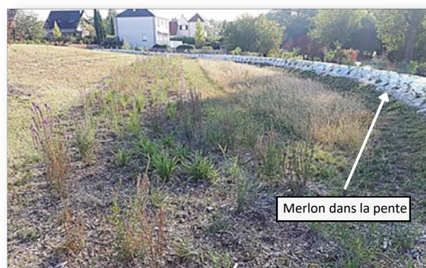
Source : Espace inondable en remblais – Forêt urbaine de la ZAC ECLO – Saint-Jean-de-Braye - INFRA Services
