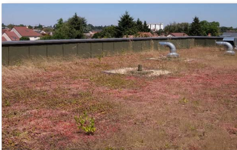
Source : Toiture terrasse végétalisée stockante – Ecole Bénédicte Maréchal, Orléans
